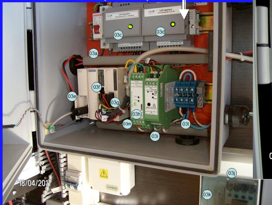
(03) Interior – Fuentes, PLC Twido y Sensores Vac,Iac (Phoenix)
